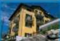
HOTEL *** Sertorelli Reit Meuble BORMIO Via Monte Braulio, 4 Tel. (+39) 0342 902 424 www.bormio.it/viamontebraulio
