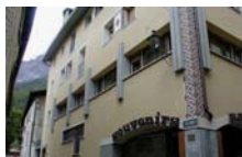
APPARTAMENTI Appartamento Marco BORMIO Via Trento, 2 Tel. (+39) 0342 90 21 16
