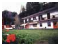
HOTEL ** La Pineta Camping ISOLACCIA - Via Le Runi, 16 Tel. (+39) 0342 985 365 www.valdidentro.it
