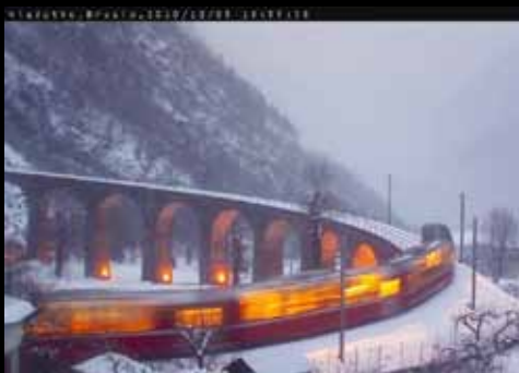
Il Trenino Rosso sul viadotto di Brusio
