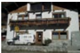
ELETRICISTA DEI CAS IMPIANTI ELETTRICI Bormio Via Monte Cristallo, 13 Tel. 0342/902.727
